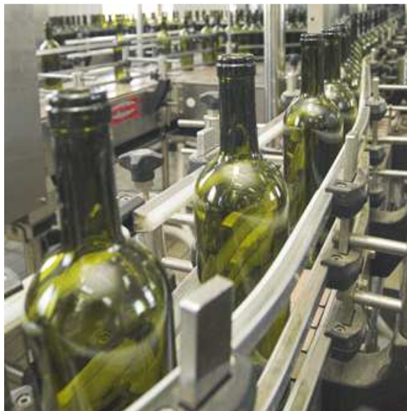
Trattamento delle linee di imbottigliamento
